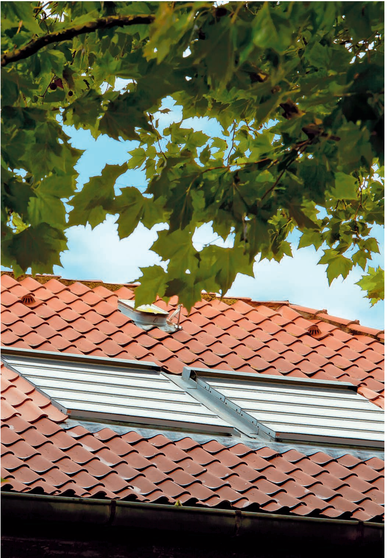
Das Dachgeschoss der Volkshochschule Lübeck wird durch vier grosszügige Dachfenster erhellt. | Les combles de l'Université populaire de Lübeck sont éclairées par quatre grandes fenêtres de toit.
