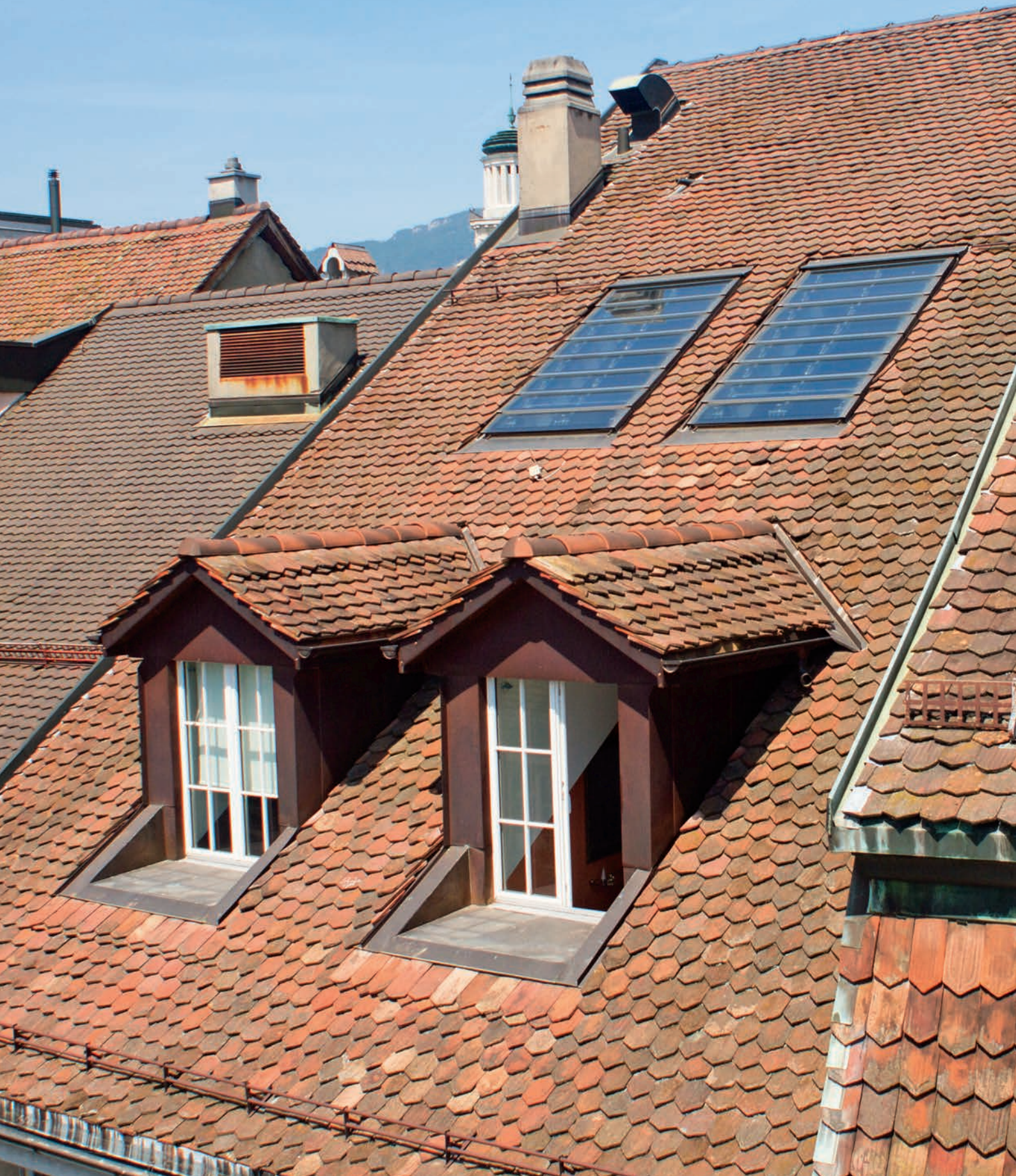
Die beiden Lamellendachfenster schaffen nebst den bestehenden Giebelfenstern zusätzliche Lichtquellen. | Les deux fenêtres de toit à lamelles ajoutent de la lumière aux deux pignons existants.
