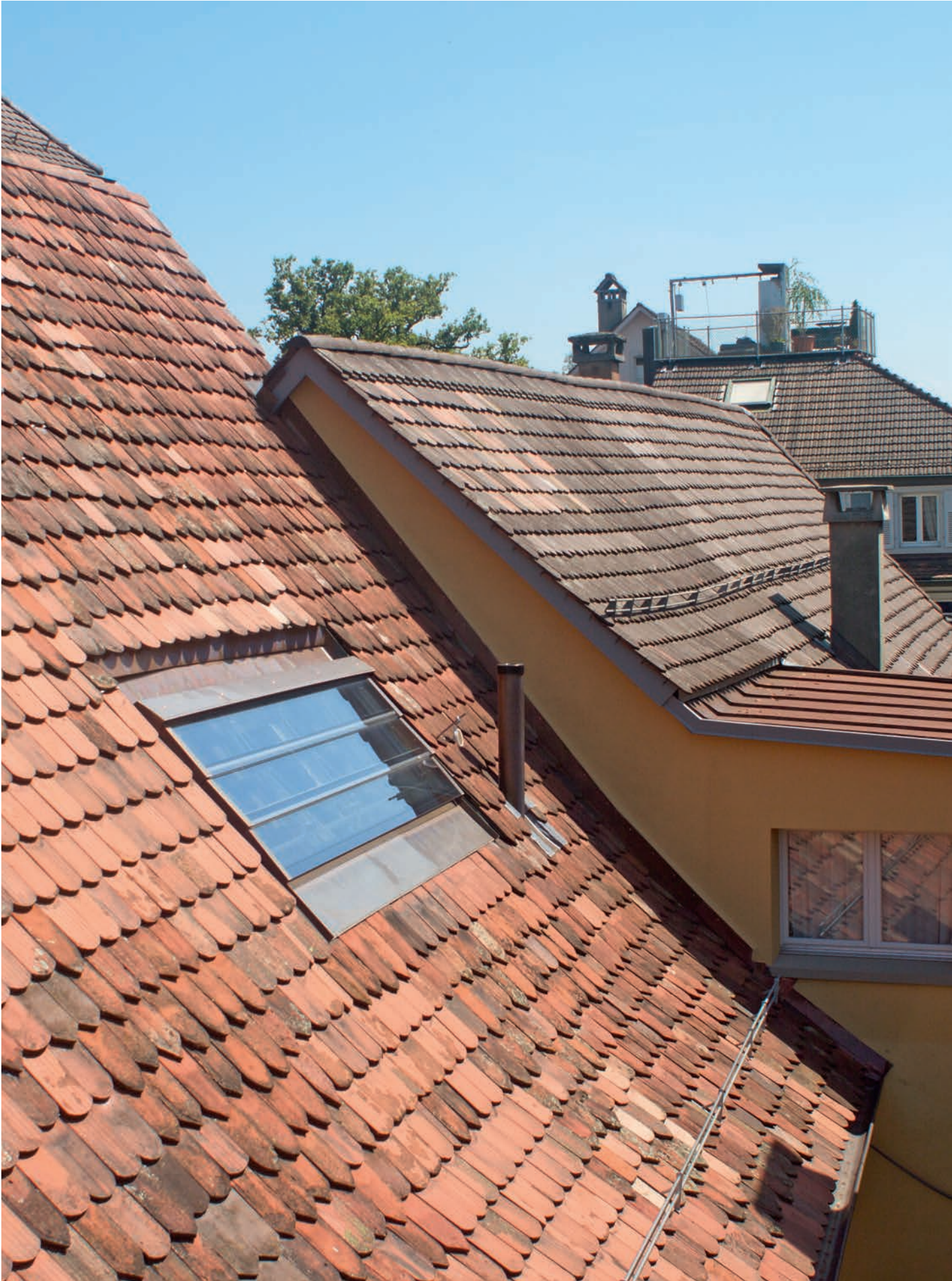
Trotz strengem Altstadtreglement wurden die Dachfenster s:201 von der Altstadtkommission für die original getreue Liegenschaft aus dem späten 17. Jahrhundert bewilligt. | Malgré la sévérité du règlement de la vieille ville, les fenêtres de toit s:201 ont été agréées par la commission ad hoc pour cette propriété bien conservée datant de la fin du 17 ème siècle.
