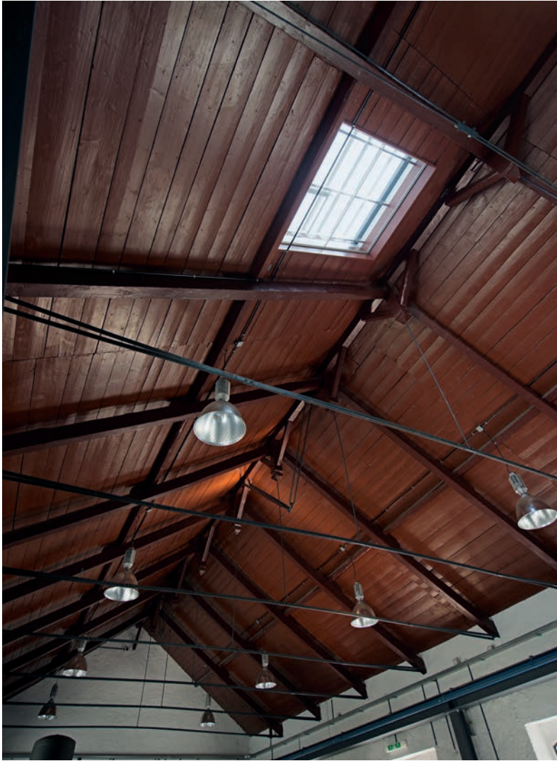
Das Dachfenster optimiert die Nutzung des Tageslichts. La fenêtre de toit permet de profiter de la lumière du jour.
