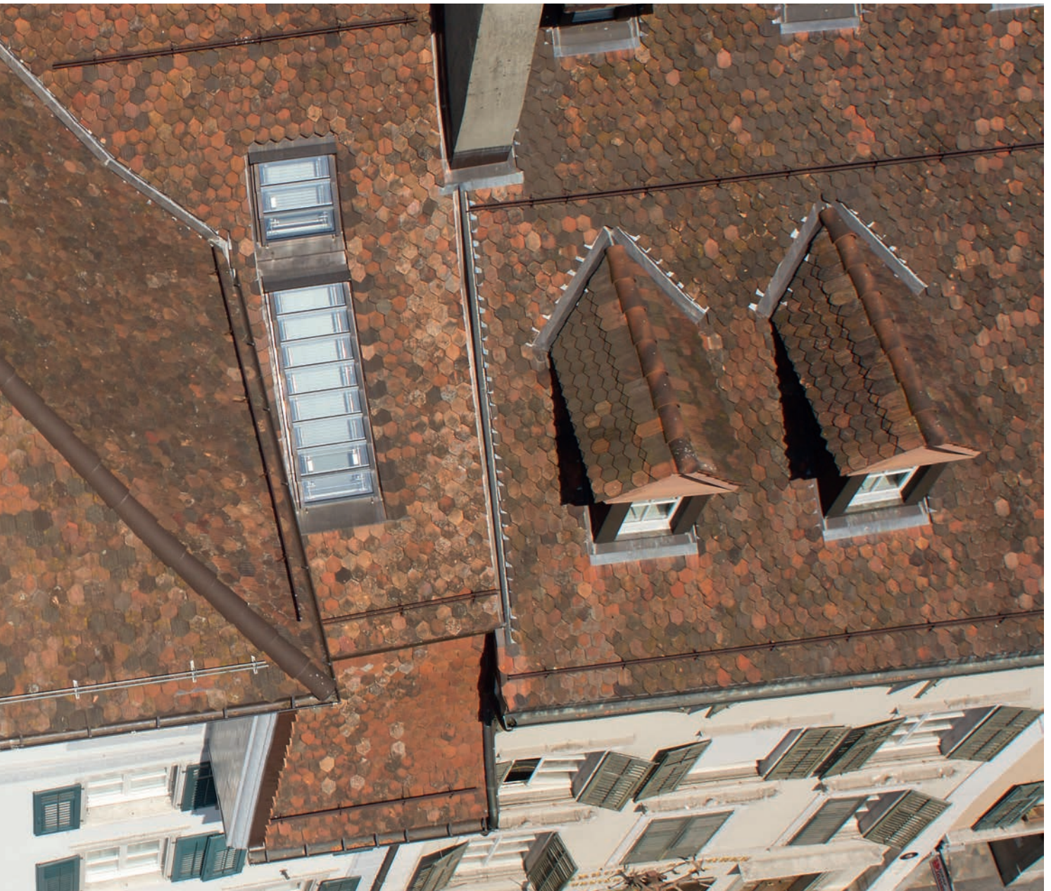
Die länglichen Lamellendachfenster fügen sich äusserst platzsparend in jede Art von Dach ein. | Grâce à leur encombrement réduit, les fenêtres de toit longitudinales s'intègrent facilement dans les toits de tous genres.
