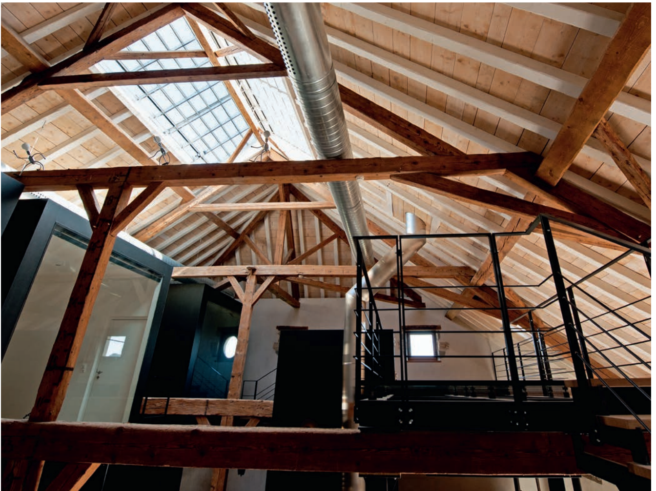
Die Lamellendachfenster sorgen für grosszügigen Lichteinfall auf die verschiedenen Ebenen des Innenraums. Les fenêtres de toit à lamelles procurent une luminosité agréable aux différents niveaux de l'espace intérieur.
