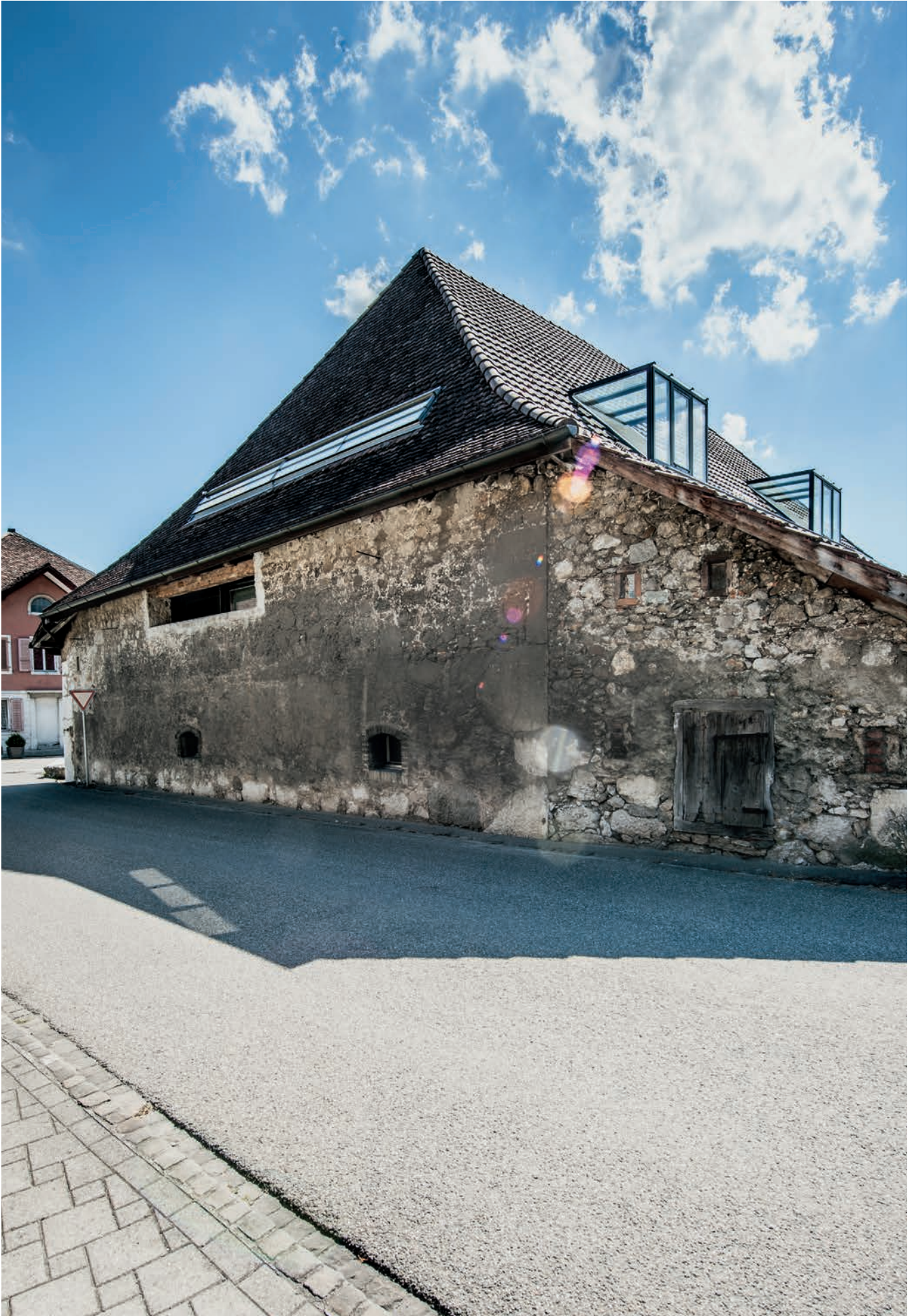
Die langgezogenen Fenster auf beiden Breitseiten des Dachs sorgen für eine optimale Belüftung und Belichtung. | La fenêtre allongée sur les deux grands côtés du toit assure une ventilation et une luminosité optimales.
