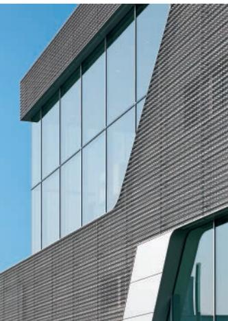
**Praktisch und bewährt.** Die Grundkonstruktion der s:stebler-Glasfassaden ist bestehend: Einer filigranen Chromstahlkonstruktion sind Lamellenverglasungen vorgehängt – diese bilden eine durchgehende «Glashaut». Die Lamellen können über einen Handtaster oder das Gebäudeleitsystem angesteuert und elektrisch geöffnet werden – stufenlos bis 90 Grad.
