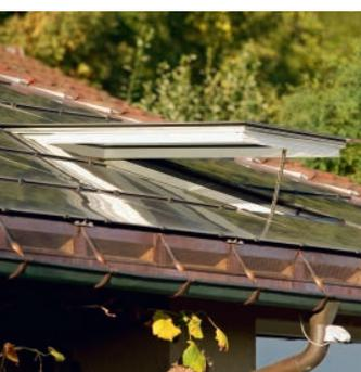
**Neuartige Konstruktionsweise.** Aussen besteht das Dachfenster s:213 ganz aus Glas (Einscheiben-Sicherheitsglas 5 mm). Innen umläuft ein isolierter Aluminiumrahmen die Konstruktion – er ist farblos eloxiert oder pulverbeschichtet in jeder RAL-Farbe erhältlich. Der Scheibenzwischenraum beträgt 16 Millimeter, die zweite Scheibe besteht aus Verbund-Sicherheitsglas (8.2 Silverstar).
