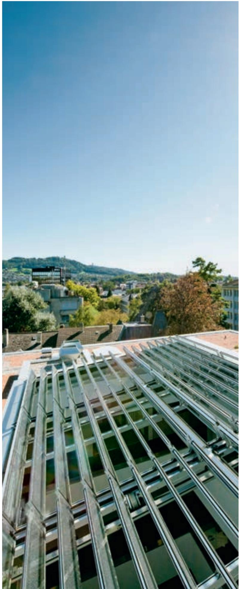
Brandschutz: Die NRW-Anlage öffnet die Lamellen im Brandfall vollautomatisch.
