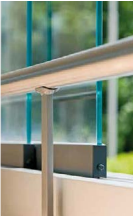
Ein neu installierter Handlauf dient als fixe Absturzsicherung
