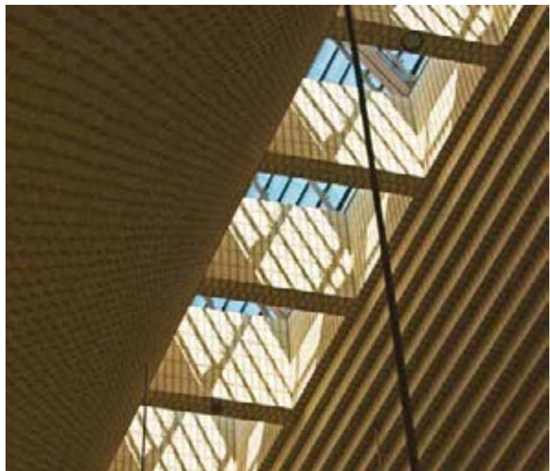
Lamellenverglasung im Dach
