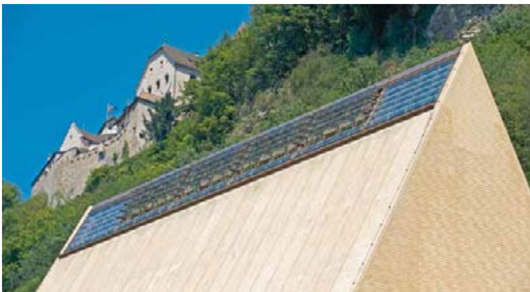
Eindrucklich: 36 Meter misst das verglaste Dachelement, 63 Grad die Neigung
