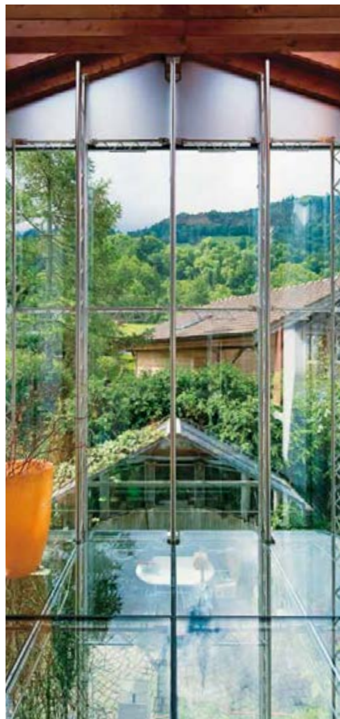
Metallkonstruktion und Glasböden überzeugen
